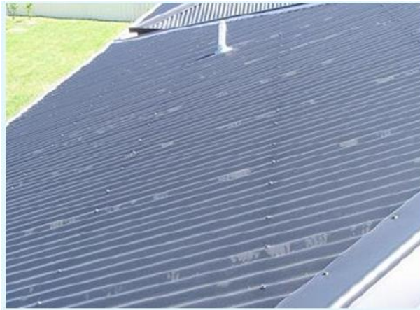
Hình 2: Hư hại của mái do ánh nắng mặt trời/ Figure 2: Roofing with sunscreen damage
