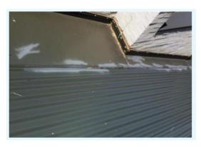
**Hình 2:** Sự xuất hiện phai màu bất thường của lớp sơn phủ trên các tấm hàng rào/ *Irregular faded appearance of touch-up paint on fencing panels*.
