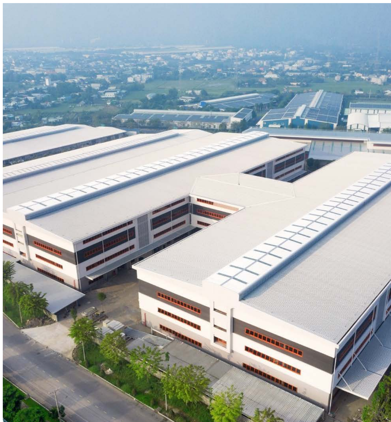
KHU NHÀ XƯỞNG XÂY SẴN CÓ DỊCH VỤ KIZUNA 3 - LONG AN, VIỆT NAM KIZUNA 3 - THE READY SERVICE SPACE - LONG AN, VIETNAM
