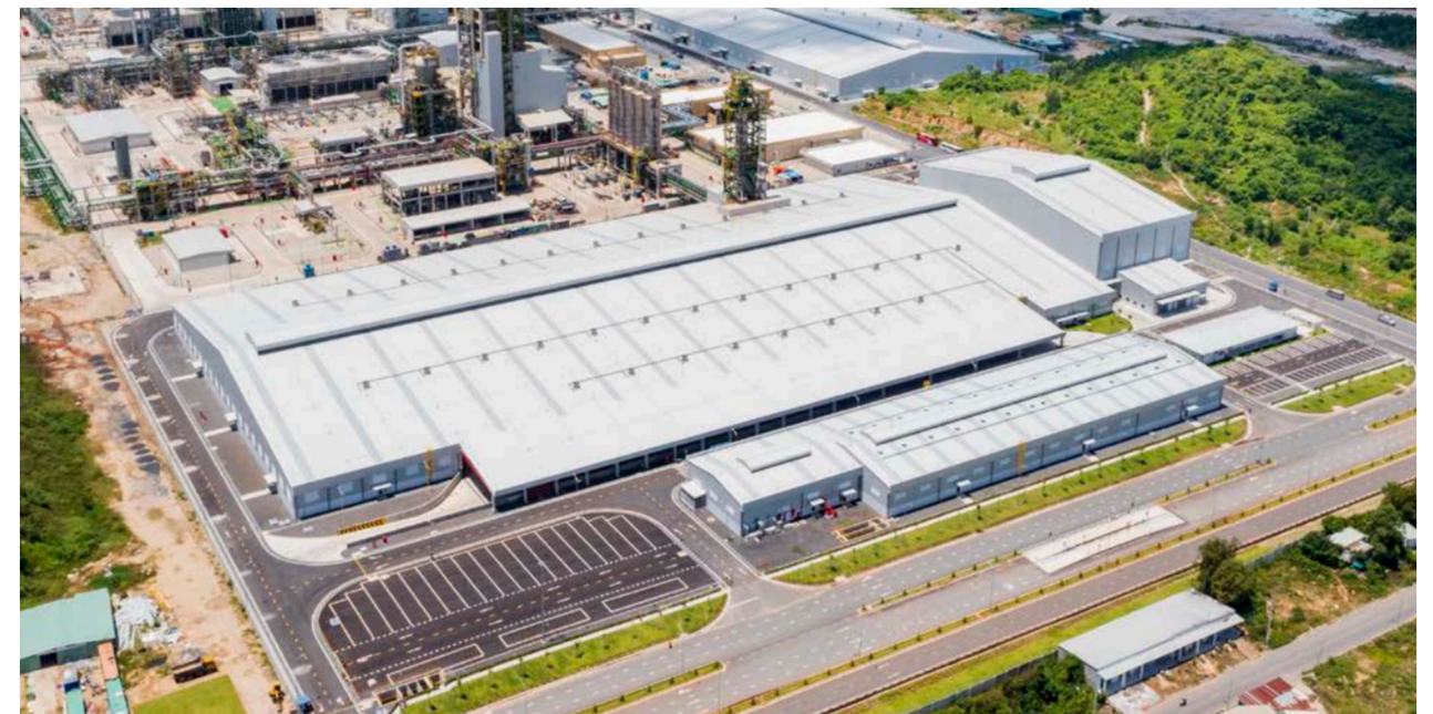
NHÀ MÁY HÓA DẦU LONG SƠN - BÀ RỊA VŨNG TÀU, VIỆT NAM LONG SON PETROCHEMICALS FACTORY - BA RIA VUNG TAU, VIETNAM
